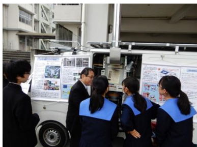
電源車の見学
